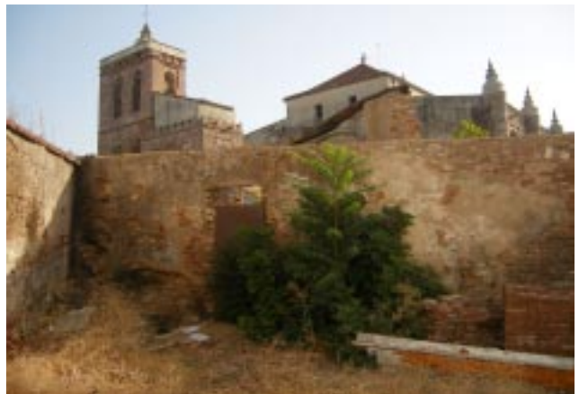
Patio de la Iglesia en estado anterior al comienzo de las obras
